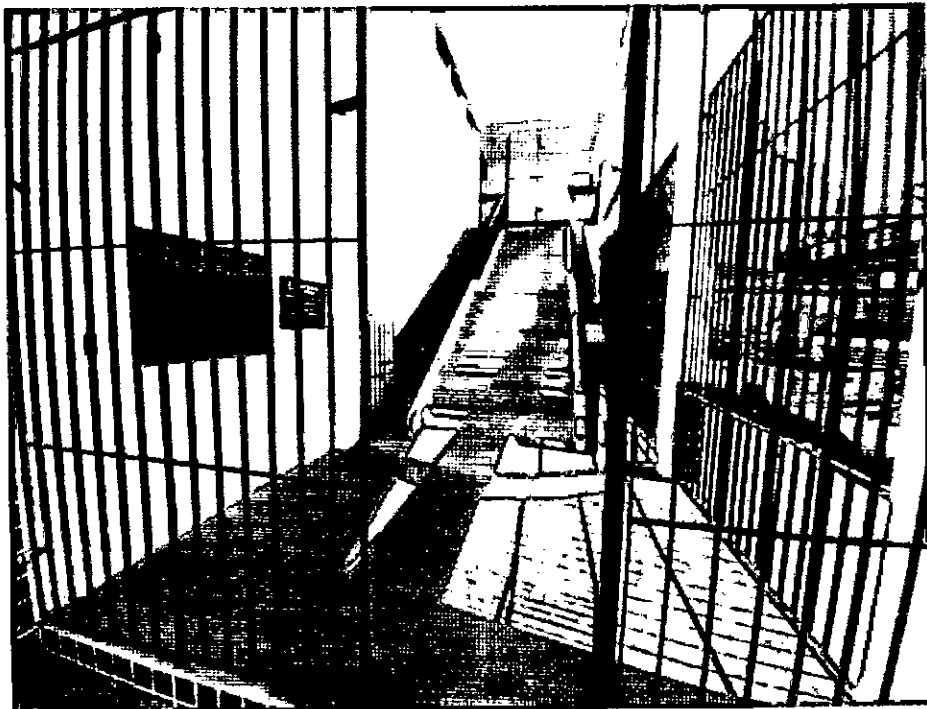
Local para instalação da Plataforma Inclinada de Acessibilidade IESAB.
